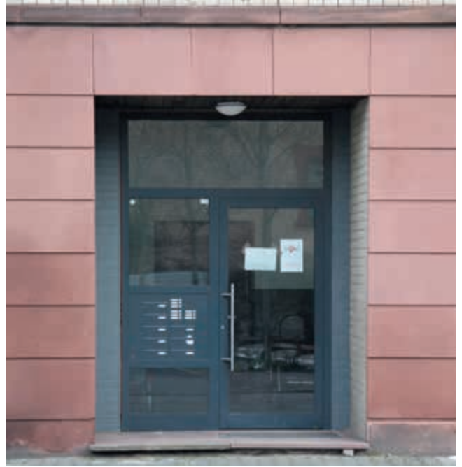
In das Fassadenbild integrierte neue Türanlage
