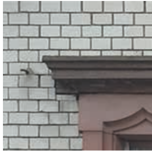
Backsteinfassade, Details von Gewänden und Gesimsen aus Sandstein
