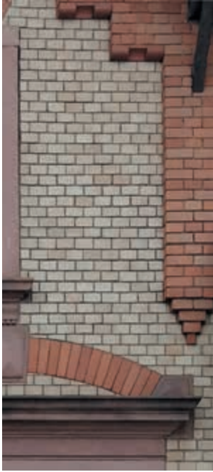
Backsteinfassade, Details von Gewänden und Gesimsen aus Sandstein
